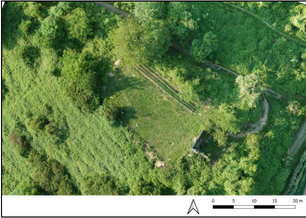
Fig. 22 – Ortofotopiano di dettaglio dell'area rilevata con in evidenza i resti della torre e la spianata ad essa antistante (Elaborazione M. Tremari).
