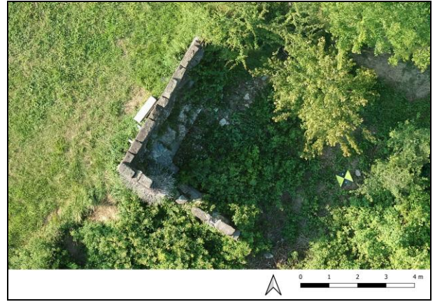
Fig. 23 – Dettaglio dei muri perimetrali della torre, visibili sull'ortofotopiano ottenuto dal rilievo aerofotogrammetrico (Elaborazione M. Tremari).
