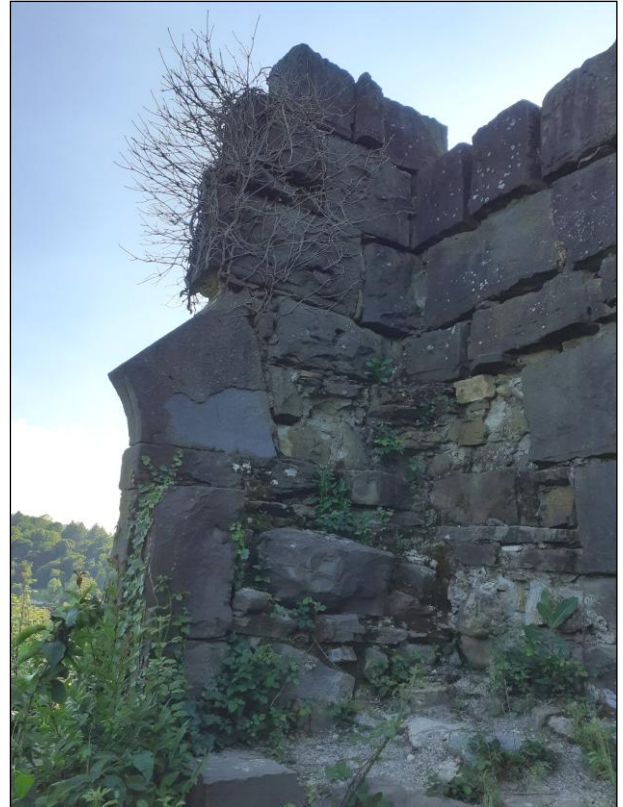
Fig. 10 - Vista del lato interno del perimetrale SO, in corrispondenza del quale si conserva, sormontato dall'imposta di un arco, lo stipite NO dell'apertura di accesso; da NE (foto M. Tremari).
