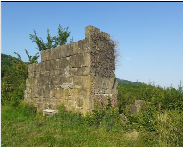
Fig. 9 - I resti dei perimetrali NO e SO della torre di Tremonte, da O (foto S. Prunerì).
