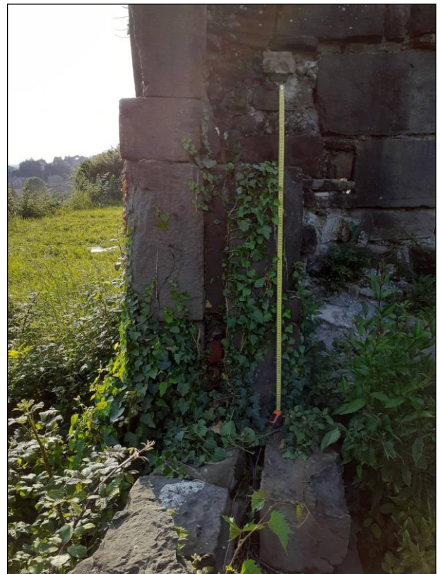
Fig. 11 - Particolare del medesimo stipite, recante una scanalatura probabilmente utilizzata per la movimentazione di una saracinesca verticale, da SE (foto S. Prunerì).
