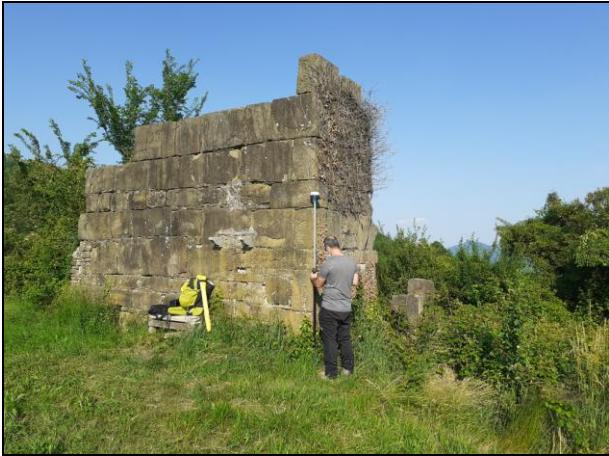
Fig. 16 - La struttura della torre durante il rilievo aerofotogrammetrico e la battuta dei punti di controllo a terra tramite sistema GNSS (foto S. Pruneri).
