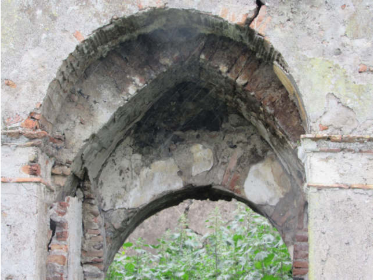
Lato nord - prospettiva su tre tipologie di archi che si sono sovrapposte nel corso dei secoli nella chiesa di contrada Nunziatella - foto Mario Guarnera
