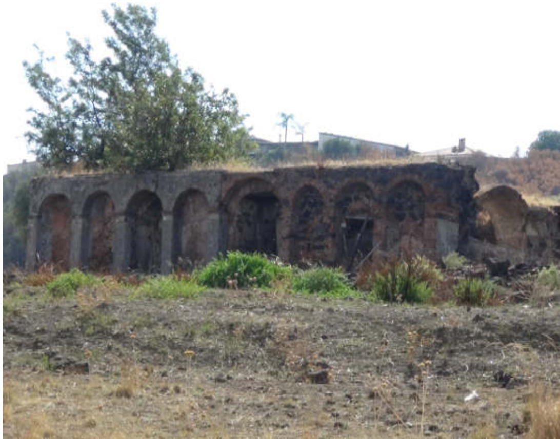
Prospetto nord della struttura - foto Mario Guarnera
