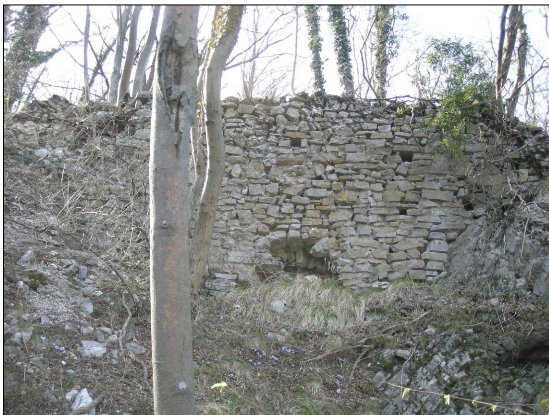
Fig. 7 - Particolare del muraglione difensivo orientale, da E (foto S. Pruneri, 2009).
