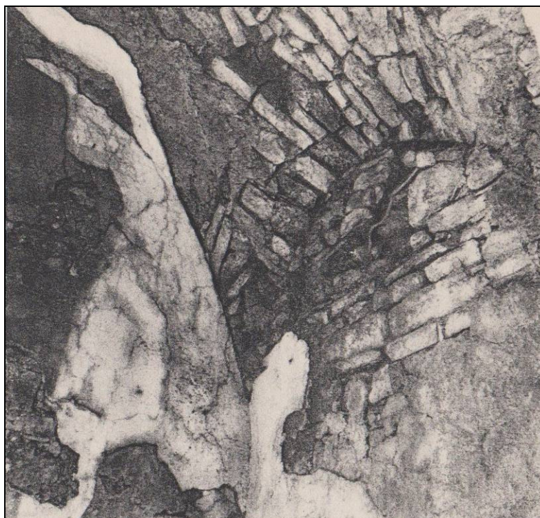
Fig. 10 - Particolare della volta dell'abside prima del crollo 8 .
