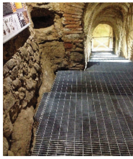
fig. 32- Granito sotto il muro divisorio
