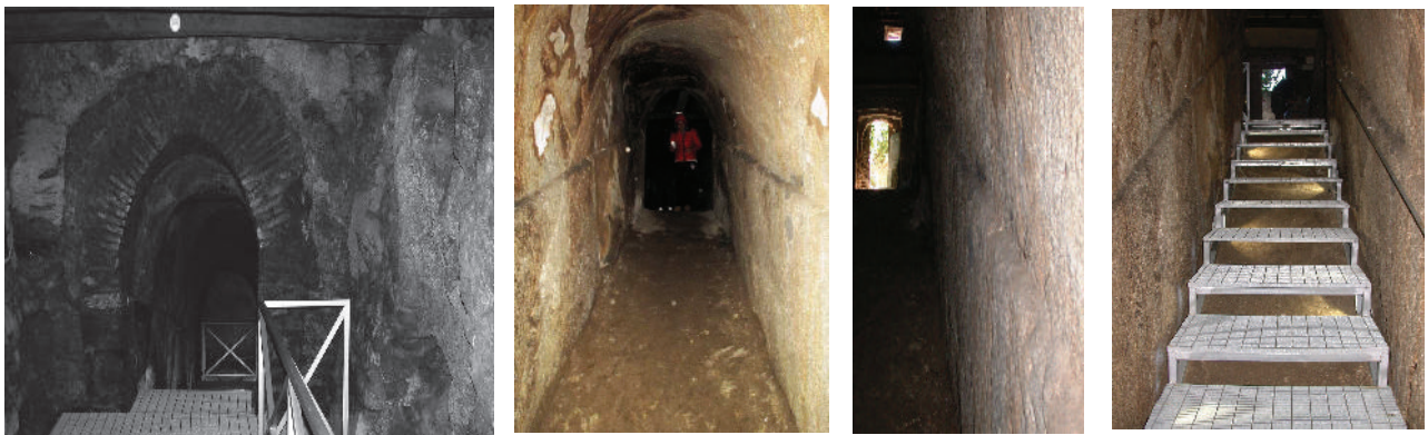
figg. 7/10 - Il vano A e la porta del dromos foderata nel XVIII/XIX sec. in pietre e laterizi; il dromos B prima e dopo l'intervento di 'valorizzazione'
