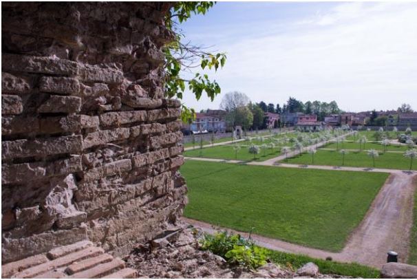
Foto 11: veduta esterna della Rocca di Sala Baganza
