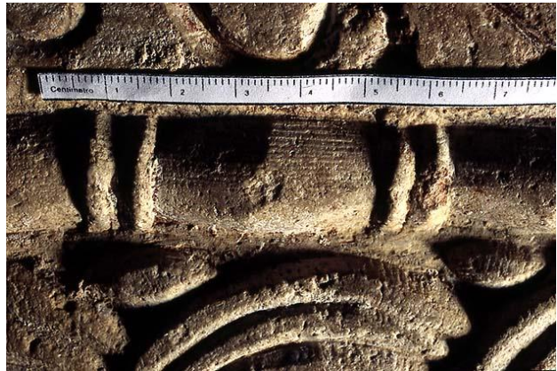
Fig. 20 Tracce di raschietti presso il motivo dell'astragalo a bambù.
